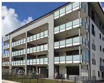
Bj. 2014, EA-B, HZG Erdwärme, 49 kWh/(m²a)
